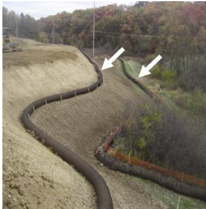
Interceptions des écoulements avec boudins (Source : AFB)
