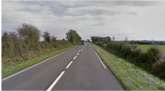
La connexion sur l'actuelle RN147 impactera fortement le linéaire arbustive / bocager accompagnant la voie. (Source Google)
