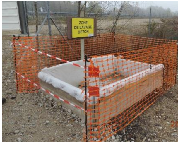
Fosse à béton (Source : Ingerop)
